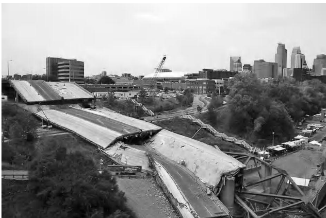
شکل ۱-۱: فرو ریختن پل I-35 در میناپولیس، مینسوتا، ایالات متحده آمریکا
