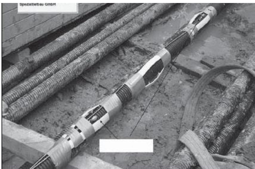
شکل ۳-۷: استفاده از سنسورهای PH در داخل سازه بتنی برای تشخیص خوردگی
