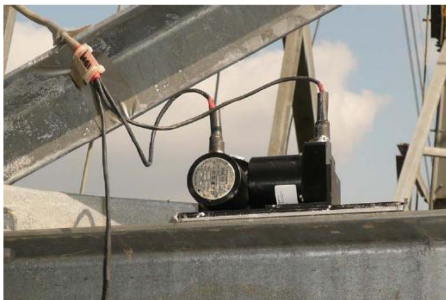
شکل ۱-۱۴: سنسور شتاب سنج نصب شده بر دکل انتقال برق (تایوان)
